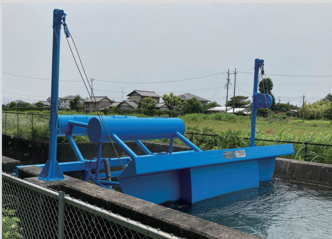
▲ 水流に加え、流れてくる葉などの継続的な衝撃に耐えるリックファイバーには、炭素繊維（カーボンファイバー）が含まれる。
